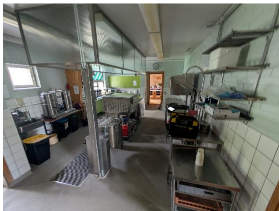
Seinien laatoituksissa on raskasmetalleja isossa keittiössä
