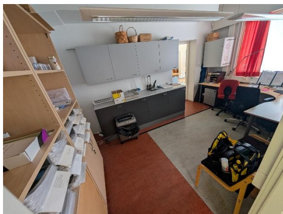
Raskasmetalleja sisältäviä muovimattoja toimistoissa
