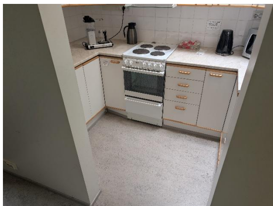
Raskasmetalleja sisältäviä muovimattoja ja välitila-laatoitusta toimiston keittiössä
