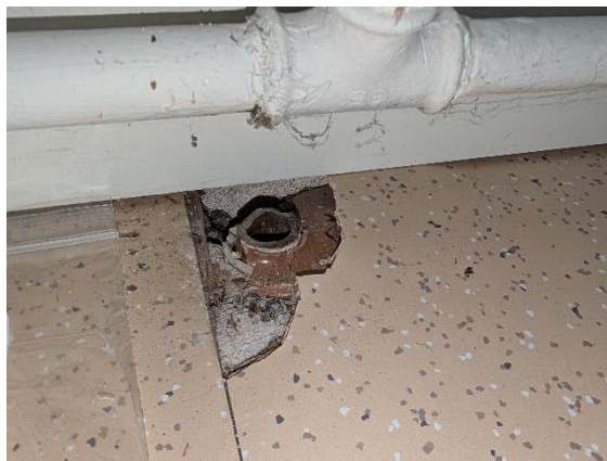
Asbestia sisältäviä vinyylilaatoituksia diakonissan toimistossa
