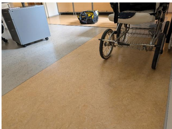
Raskasmetalleja sisältäviä muovimattoja toimistoissa
